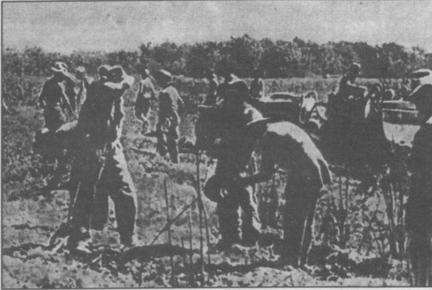
Строительство посадочной площадки в тылу японских войск
